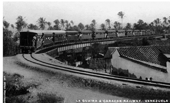
Figura 6. Viaducto de Pariata.
