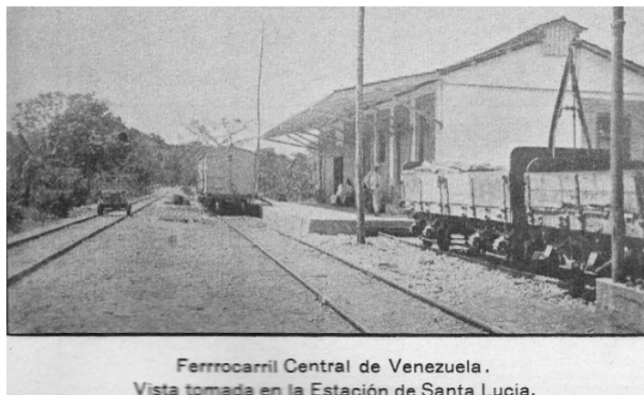
Figura 13. GFC. Estación Santa Lucía.
