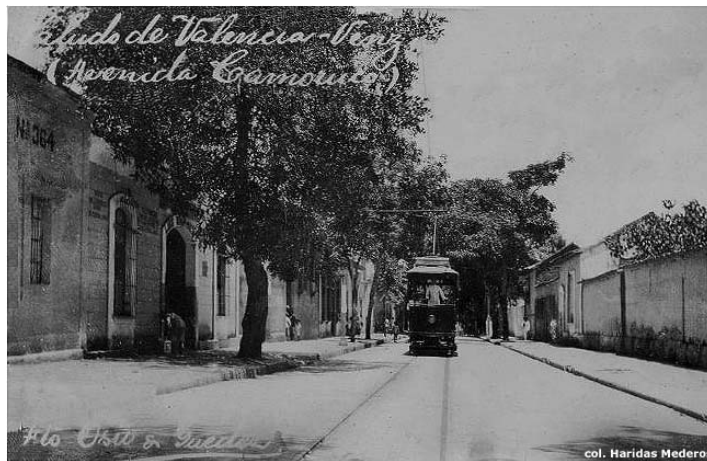
Figura 48. Valencia, tranvía eléctrico, Av. Camoruco. F/ Morrison.
