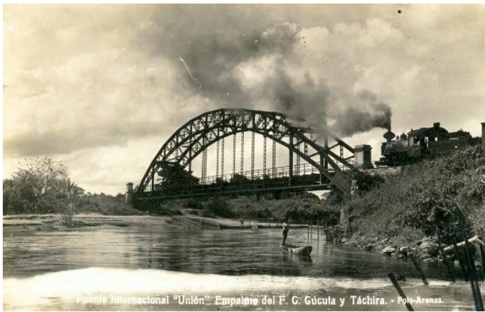
Figura 27. Puente Internacional Unión sobre el río Grita.
