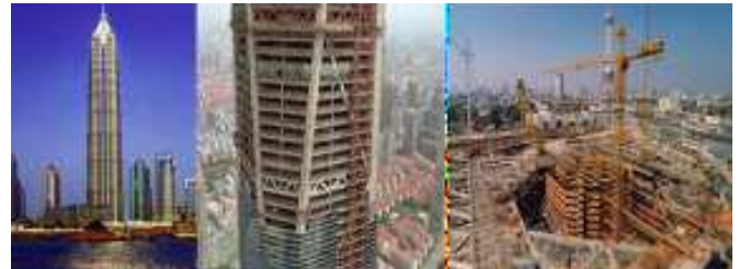
Foto: Jin Mao Tower . En construcción
