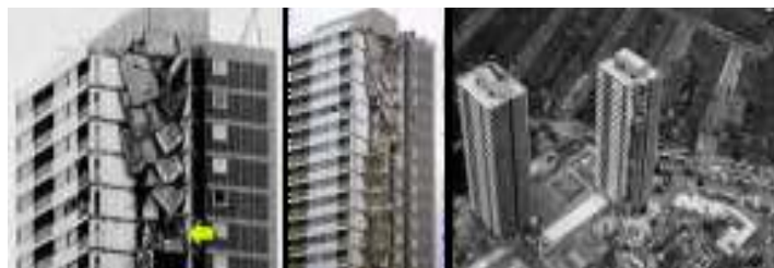
Foto: Ronan Point después antes de la explosión.
