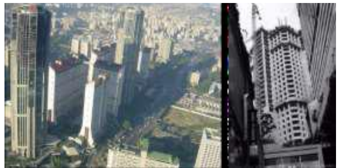
Foto: Parque Central. Edificios residenciales 44 pisos. Torres de oficinas 54 pisos.
