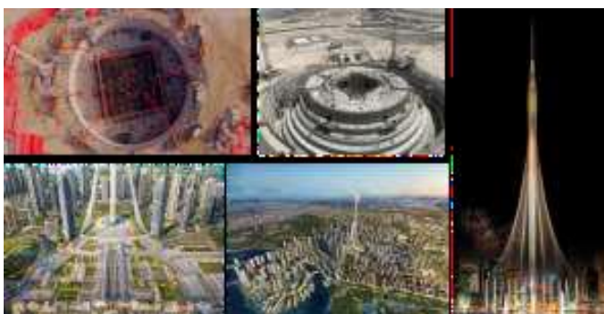
Foto: Dubai Creek Tower en construcción.
