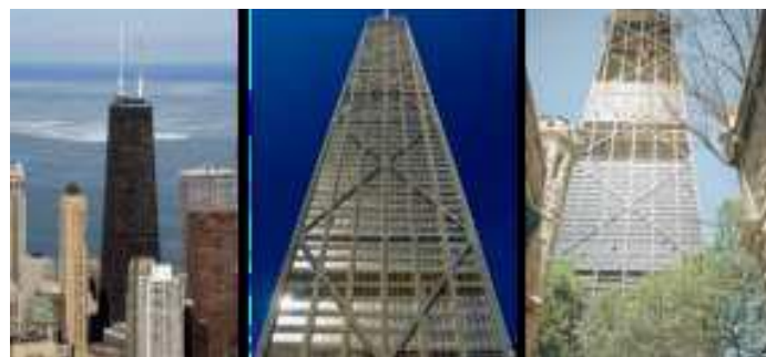
Foto: John Hancock Center . En construcción.
