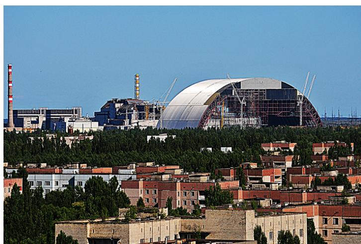
Vista panorámica del Central Nuclear Vladimir Ilich Lenin, mundialmente conocida como Central Nuclear de Chernóbil. En primer plano la ciudad fantasma de Prip'yat. Al fondo, al lado del malogrado reactor, el nuevo sarcófago (o, por su nombre en inglés, New Safe Confinement) que pondrá a resguardo el letal contenido por un siglo más. Toneladas de combustible continuarán ardiendo por miles de años.
