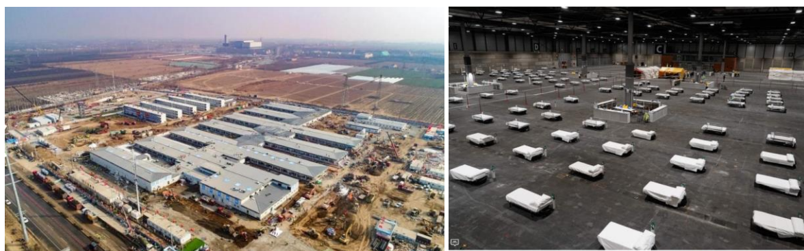
Figura 29. Hospitales de emergencia: Wuham, China, F/ https://www.archdaily.cl/cl/937687/una-mirada-de-cerca-a-los-hospitales-en-china-construidos-para-controlar-la-pandemia-del-covid-19 ; y hospital de emergencia en el Predio Ferial de Madrid (IFEMA) F/
