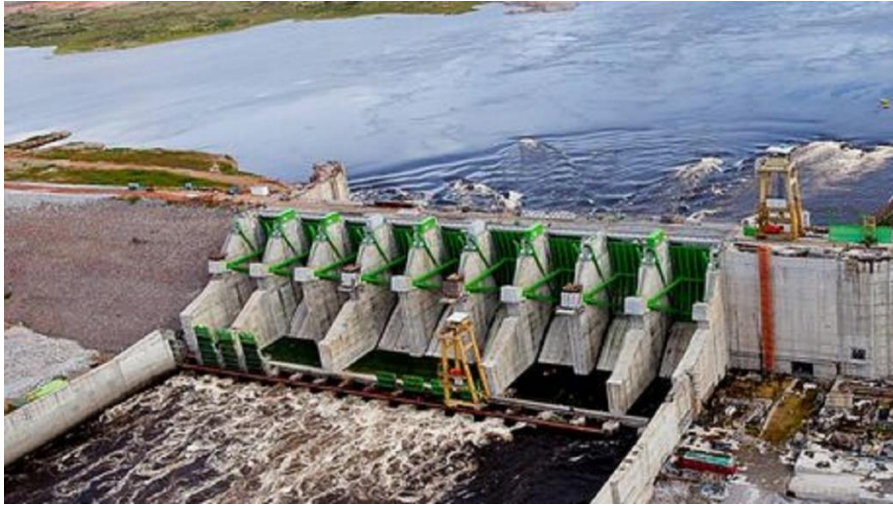
Figura 17. Represa de Tocomá en construcción desde 2002.
