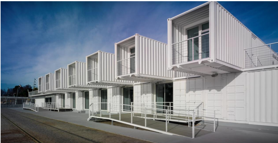
Figura 34. Reciclaje de contenedores. Terminal de cruceros de Sevilla. F/
