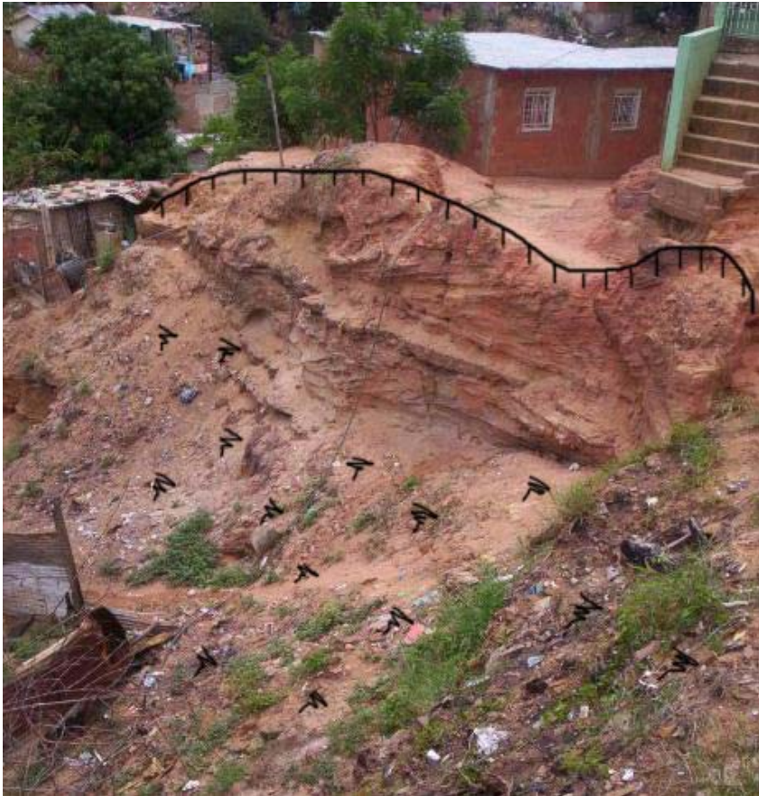
Figura 2. Cicatriz de desprendimiento de material rocoso y escurrimiento laminar. A la izquierda, se observa una vivienda colapsada en el barrio Cerros de Marín
