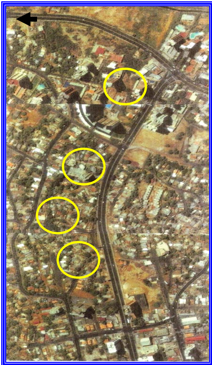
Fuente: Imagen satelital. Corporación Alcaldía de Maracaibo, 1996 Figura 10. Vista Aérea de zonas de derrumbes y deslizamientos. Barrio Cerros de Marín, municipio Maracaibo, estado Zulia.
