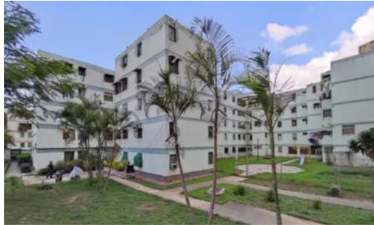
Imagen 18. Vista de conjunto del edificio tipo IM5
