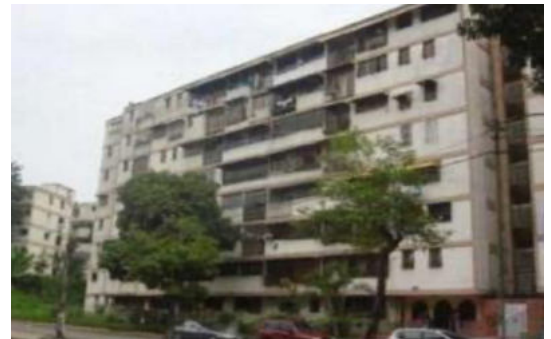
Imagen 13. Vista del edificio tipo 6M8
