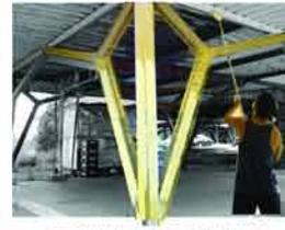
Si los elementos metálicos tienen todas o parte de sus caras vistas y con pintura, esas superficies deben permanecer limpias para que la pintura y la base estén en las mejores condiciones de durabilidad.
