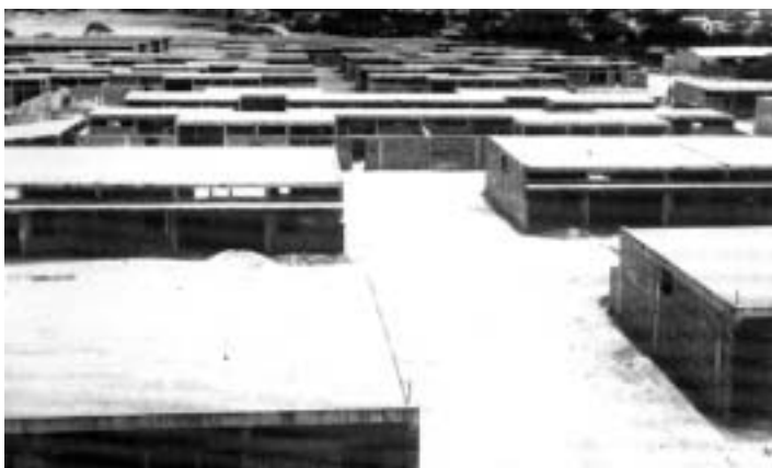
FIGURA 15 Vivienda urb. Pomona, Maracaibo
