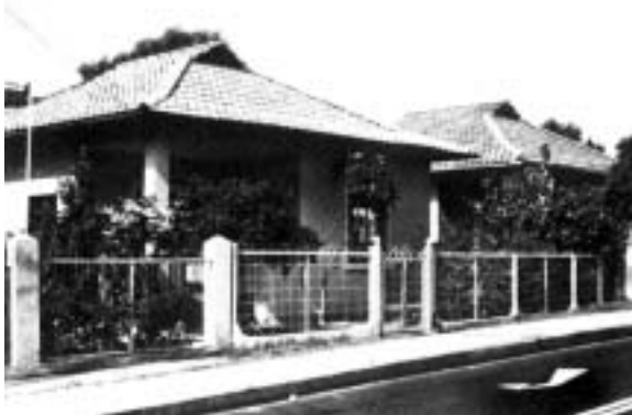
FIGURA 16 Vivienda Urb. Bella Vista. Maracaibo
