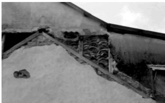
FIGURA 2 Bahareque a la vista con relleno de coco
