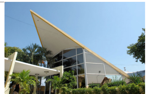
Figura 59 Cubierta del Colegio de Médicos del Zulia
