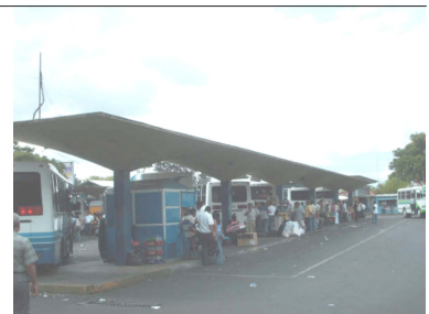
Figura 39 Andenes de paraboloides hiperbólicos en la Terminal de autobuses de Barinas
