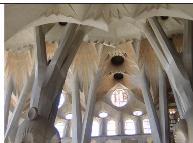
Figura 3 Bóvedas regladas en la Sagrada Familia en Barcelona, España
