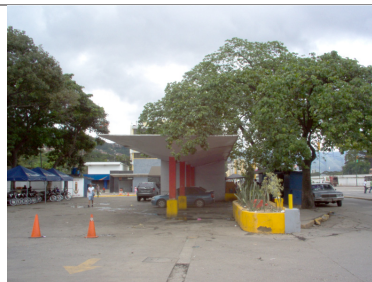
Figura 31 Paraguas invertidos de paraboloides hiperbólicos del área de servicio eléctrico automotriz, y de las oficinas de la Estación de Gasolina de Coche en Caracas.
