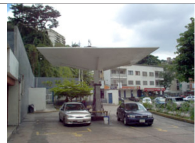
Figura 28 Estación de gasolina Av. Río de Janeiro. Caracas
