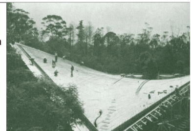
Figura 21 Capilla del Altílo una vez vaciada la cubierta
