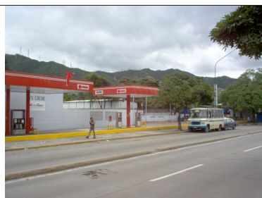
Figura 32 Estructuras metálicas ligeras con las cuales fueron sustituidos los paraboloides de concreto armado posterior a su demolición
