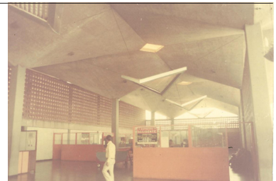
Figura 41 Terminal de autobuses de San Cristóbal. Al poco tiempo de culminar la edificación Coto Asenjo captó esta imagen de la parte interna
