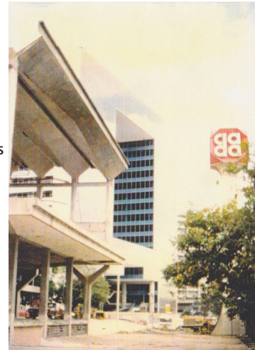
Figuras 34, 35 y 36. Fotografías inéditas captadas por el arquitecto Álvaro Coto Asenjo, donde se observan las condiciones de preservación de los paraboloides hiperbólicos de concreto armado después del incendio devastador que acabó con su funcionamiento y que conllevaría a su demolición total
