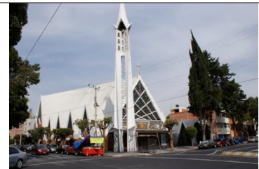
Figura 17 Vista exterior de la iglesia de La Medalla Milagrosa
