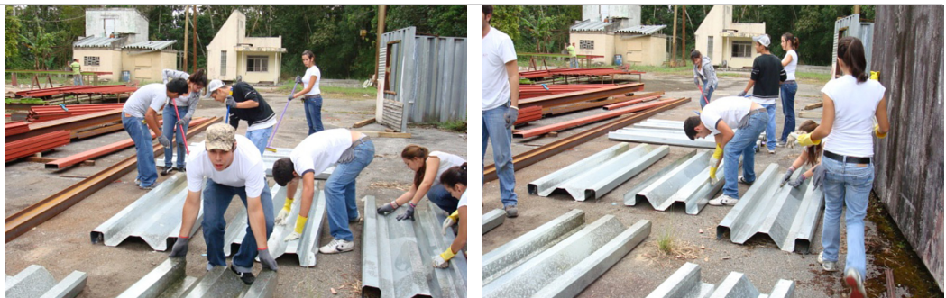
Figura 1 Alumnos realizando prácticas de ensamblaje de la tecnología Sipomat en la planta El Laurel
