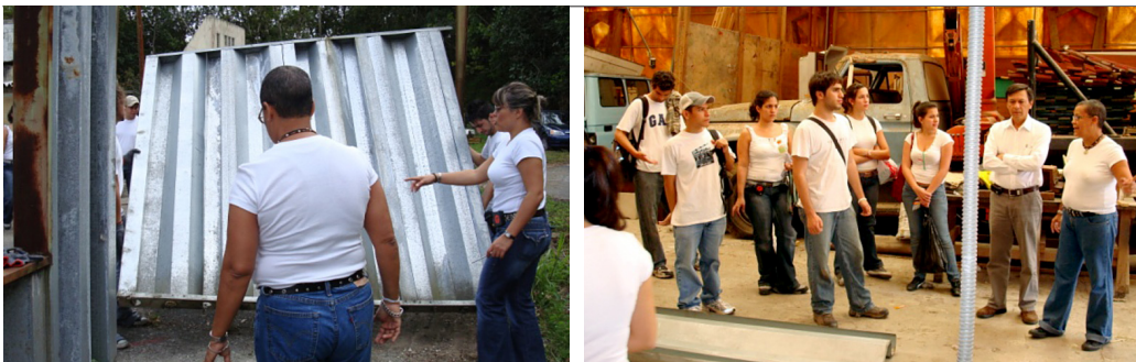
Figura 2 Izando un plano portante Sipromat en una explicación en planta
