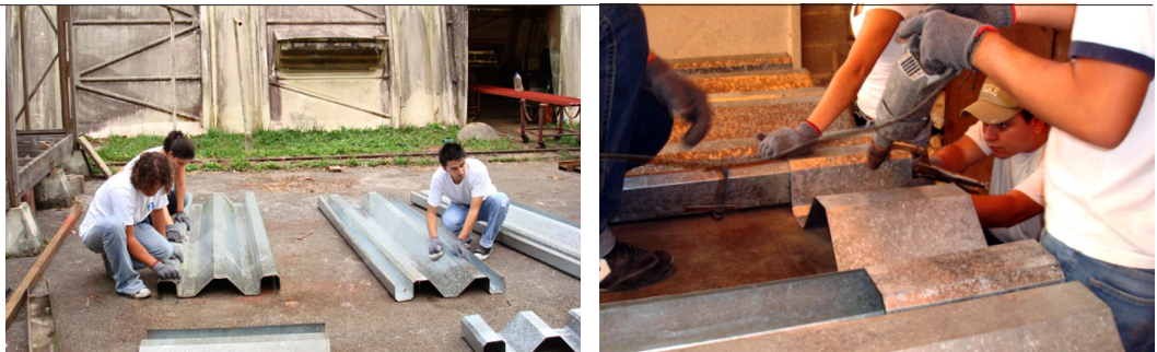
Figura 3 Estudiantes en tareas de construcción de módulos Sipromat y colocando fijaciones
