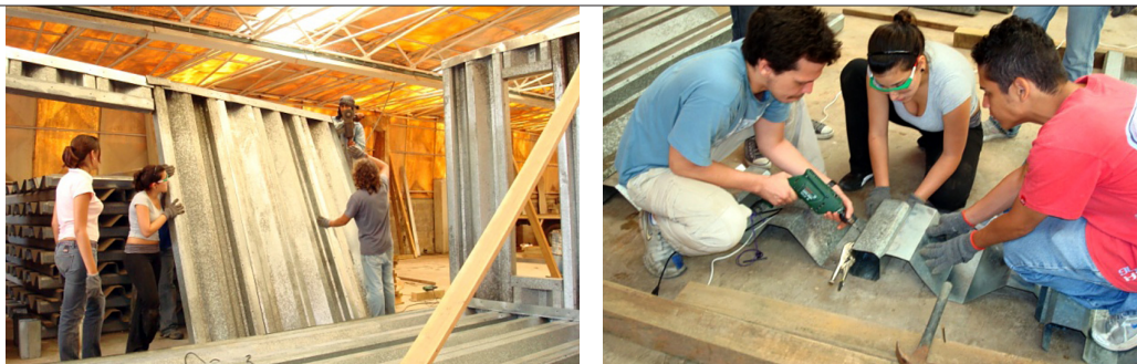
Figura 5 Estudiantes aprendiendo el manejo de herramientas de construcción armando planos portantes
