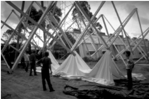
FIGURA 49 Elevación de la cubierta
