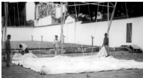
FIGURA 52 Montaje cubierta
