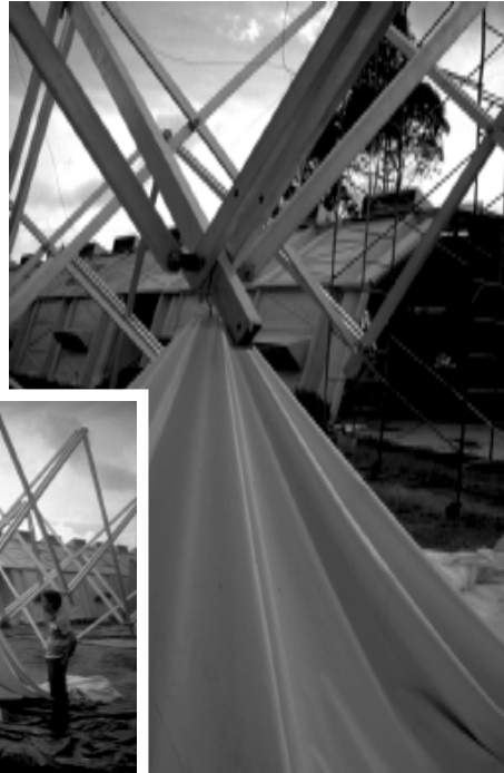
FIGURA 48 Colgado de la cubierta
