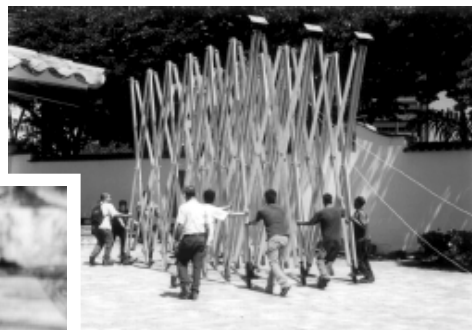
FIGURA 30 La adición de ruedas permite el transporte manual del paquete
