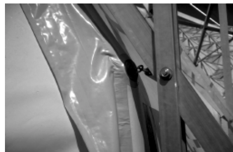
FIGURA 45 Solape y conexión lateral
