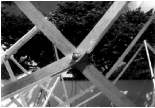
FIGURA 37 Fractura de los perfiles
