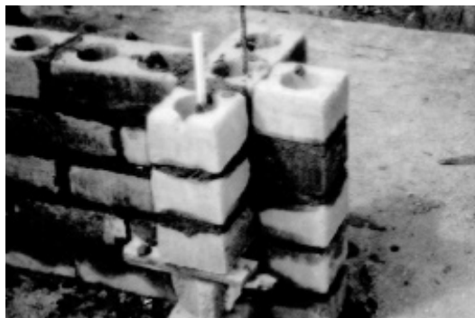
Figura 3 Detalle armado pared e instalaciones
