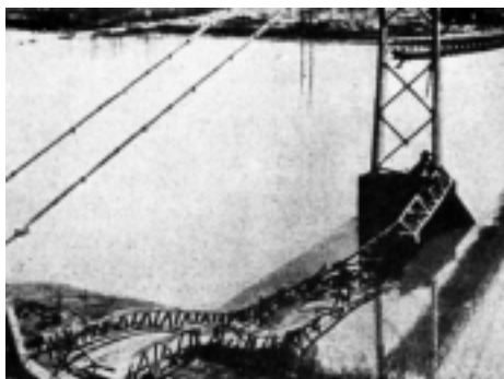
Foto 22 Puente sobre el río Peace. Derrumbe
