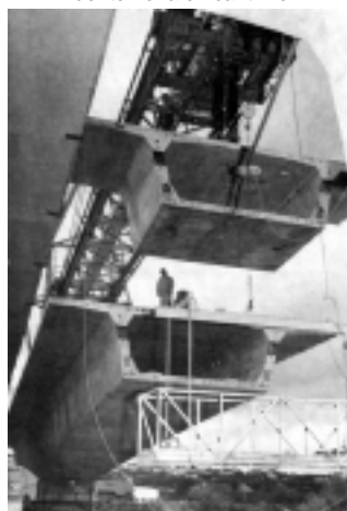
Foto 13 Puente Loira en cantiliver
