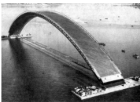
Foto 12 Puente sobre el Elorn, Francia. Andamiaje usado en los tres arcos
