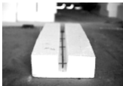
Figura 12 Detalle del nervio en el bloque de poliestireno expandido antes de vaciar el concreto
