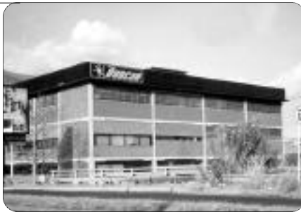
Foto 5: Conformación típica de columna corta
