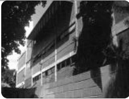
Foto 4: Conformación típica de columna corta
