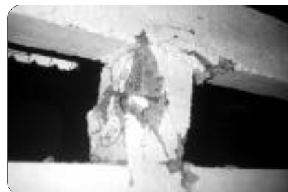
Foto 21: Falla por columna corta obtenida en el ensayo realizado en la Universidad de los Andes
