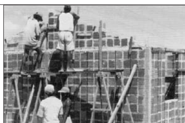
Figura 11: Construcción de una vivienda de muy bajo costo resultado de la transferencia CEVE-GRET Brasil. (Foto: CEVE).
