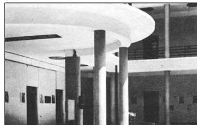
Foto 10: Escuela Gran Colombia. Vista del patio, columnas, vigas y losas de concreto.
