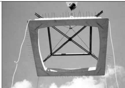
Foto 20: Ampliación del Museo de Bellas Artes de Caracas. Vista del montaje del marco.
