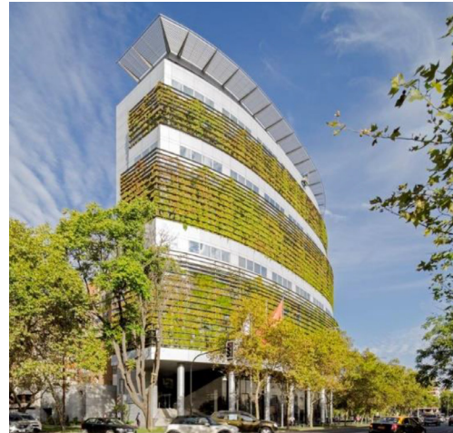
Ejemplo de fachada de doble piel vegetal con enrejados, mallas y tensores. Ayuda a reducir la absorción solar. Edificio Consorcio, Santiago de Chile.
