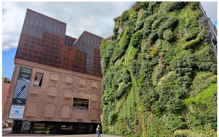
Caixaforum, Madrid: muros con sistemas hidropónicos
