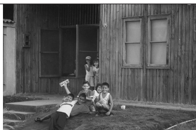
Foto 4 Vivienda AC-1 Rubio, fachada
