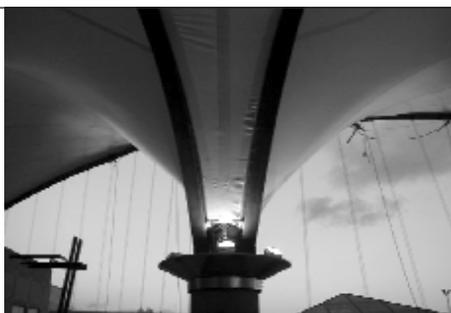
La cubierta está soportada principalmente por una pareja de mástiles metálicos compuestos que a su vez están soportados por cables sujetos a la fachada de la Torre. Los puntos de soporte sobre la fachada se encuentran ubicados sobre las vigas existentes de la estructura de la Torre. El sistema de tensado se define por los puntos de fijación de la tela a la estructura metálica y los puntos del piso (ver foto 18).
