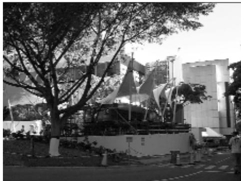
La tercera cubierta es un paraboloide soportado por un mástil en un extremo que produce un punto alto y dos puntos bajos que van directo a las fundaciones, en el otro extremo la membrana se monta sobre un pasillo cubierto y se sujeta a la viga de éste a través de cinco bases (ver foto 24).
