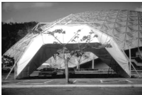
radio. Esta malla se complementa con una Membrana de Poliéster/PVC que se cuelga a la estructura de aluminio desde abajo utilizando un sistema de cuerdas y poleas.
