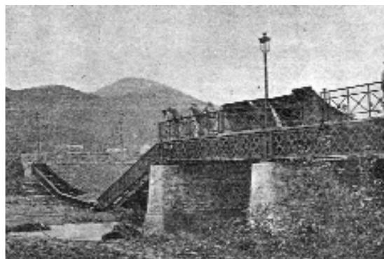
toresca Avenida del Paraíso, al pie de la serranía del sur. Este puente tiene 60 metros de luz sin apoyos intermedios; 8 de ancho y 5 de altura sobre el río. La parte de acero pesa 90 toneladas y está calculado para soportar una carga de doscientas, uniformemente repartidas» (*El Cojo Ilustrado* n° 147, 1° febrero 1898, p. 129)<sup>13</sup>.
