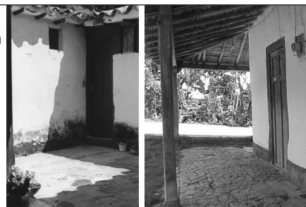
Figura 3 Captación de la energía solar. Corredores y patios externos recubiertos con piedra para captar calor.
