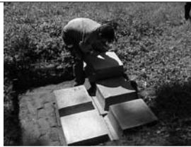
Figura 8 Componente modular prefabricado de concreto para placa de fundación superficial alveolada. Augusto Márquez
