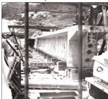
Viga pretensada vaciada en sitio
