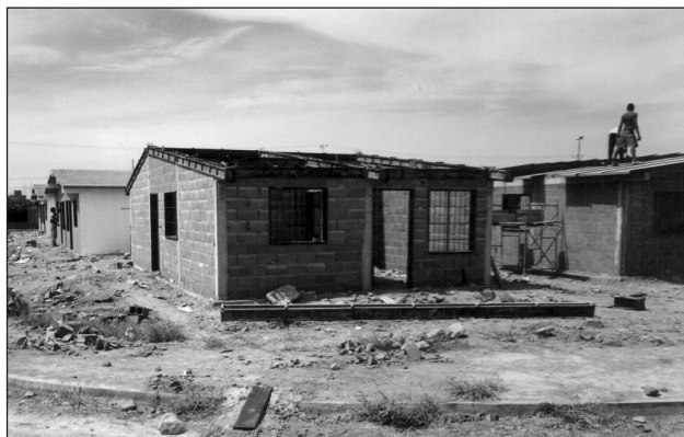
Foto 4 Estructura en concreto armado
