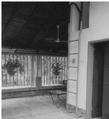
Foto 28 Contraste de colores en elementos de herrería (imagen tomada durante el proceso de pintura de la obra)
