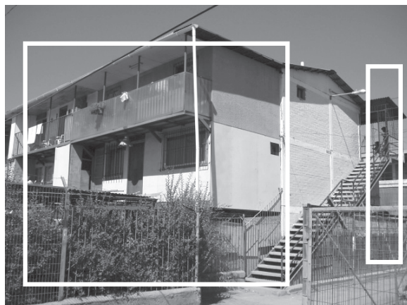
Foto 8 Urbanización Los Quiyalles, Chile. Ampliaciones anárquicas que ponen en riesgo la totalidad de la edificación y por consiguiente de sus habitantes. Véanse las ampliaciones resaltadas en la imagen por ambas fachadas de la edificación, cada una es diferente con respecto a la otra.
