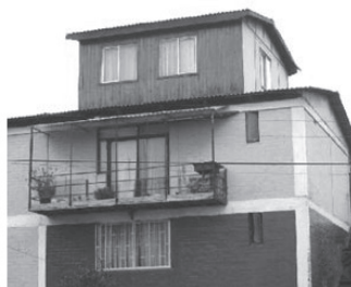
Foto 5 Vista de la transformación de varias edificaciones, con ampliaciones aisladas ejecutadas por las mismas familias.
