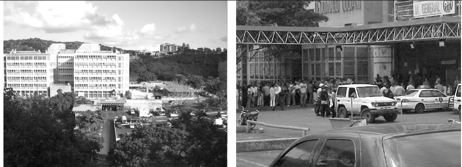
Figura 12 Hospital Domingo Luciani. IVSS. Vista general, espera de familiares y acceso de la emergencia
