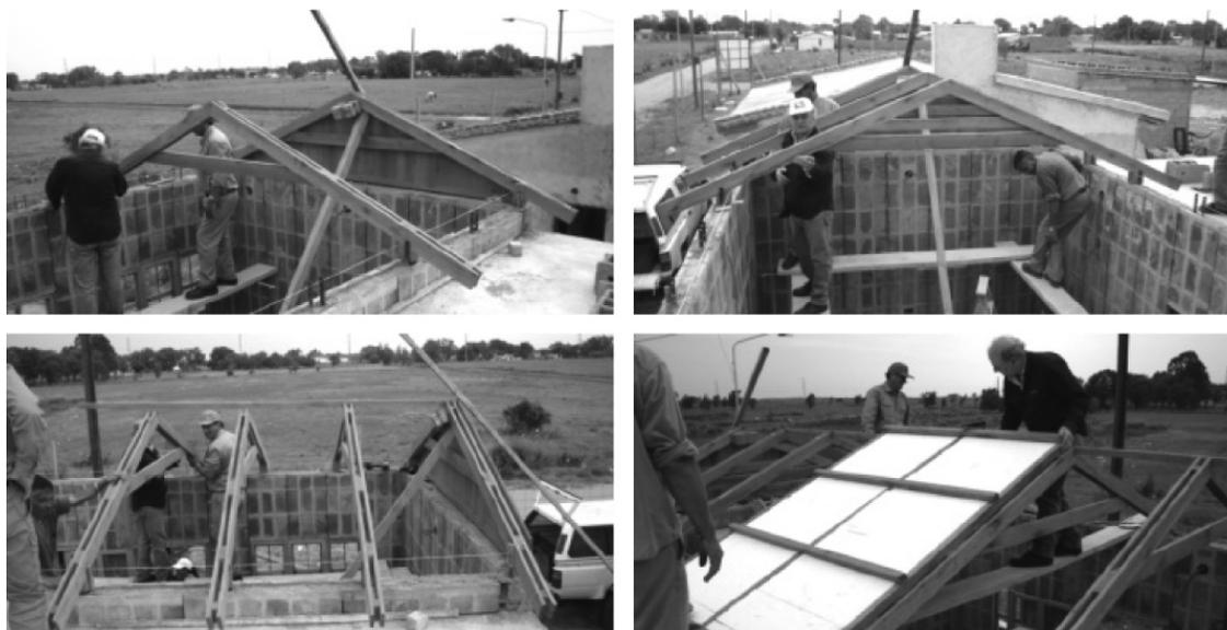
A continuación se describe catálogo de Cabriadas con **tejas francesas** para luces 3,00, 3,20, 3,40, 3,60, 3,80 y 4,00 m y catálogo Cabriadas con **láminas sinusoidales** para luces de 3,00, 3,20, 3,40, 3,60, 3,80 y 4,00 m.
