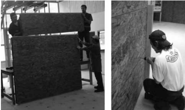
Figura 35 Refuerzo y fijación de los paneles a través de tornillos
