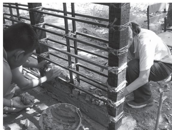
Foto 11 Rellenando el panel
