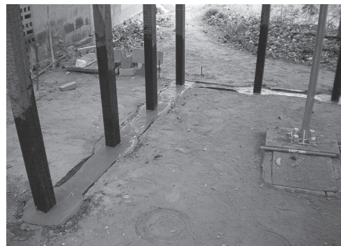
Foto 5 Zanja terminada
