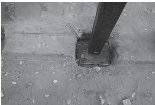
Foto 3 Horcón enterrado y relleno de concreto
