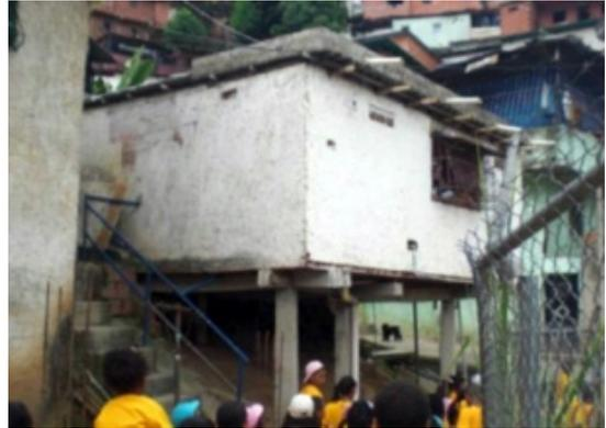
**Foto 9** - Contención falsa al construir paredes sólo para ocultar los pórticos de la estructura
