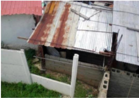
**Foto 7** - Vivienda sin contención, sólo con columnas apoyadas y enterradas en el suelo
