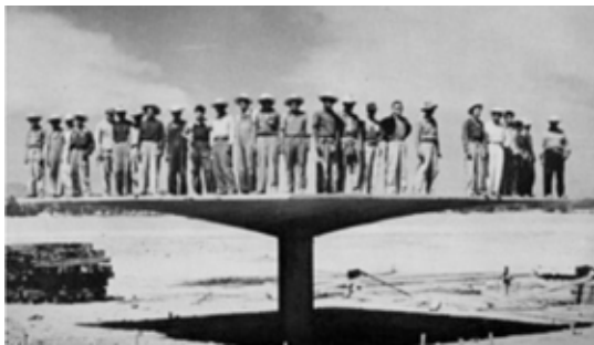
Paraguas invertido, concreto armado "...con dimensiones de 8 X 8 m y flecha de 60 cm." (Faber, 1970:84). Almacén de las Aduanas (1952), México, D.F. Fuente: Faber, 1970
