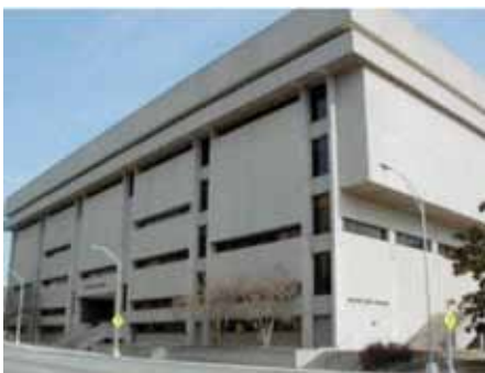
1968. Escuela de música Juilliard School, ubicada en en el Lincoln Center. Proyecto ejecutado junto a Pietro Belluschi Fuente: https://es.wikipedia.org/wiki/Escuela_Juilliard
