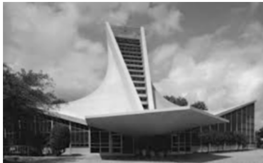
Eje Z no vertical. Capilla de San Vicente de Paúl en Coyoacán, México, 1959-1960. Arquitectos Enrique de la Mora y Fernando López Carmona. Fuente: www.revistas.unam.mx
