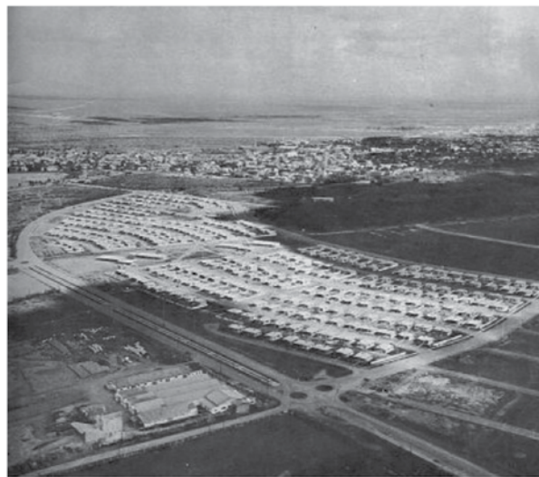
Vista aérea de la construcción de la 1ª etapa
