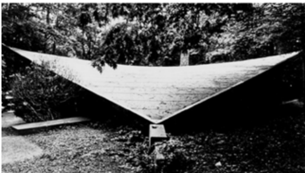
Figura 6. Vista exterior de la cubierta de doble curvatura del paraboloides hiperbólico fabricado por Eduardo Catalano para su vivienda en Carolina del Norte
