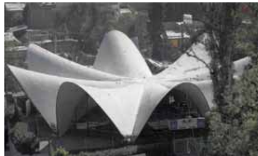
Bóveda por arista. Bóveda por arista de 8 pétalos formados por la intersección geométrica de 4 paraboloides hiperbólicos en concreto armado. Restaurant Los Manantiales (1958) diseño arquitectónico de los hermanos Joaquín y Fernando Álvarez Ordoñez, Xochimilco, estado de México. Fuente: www.piterest.com
