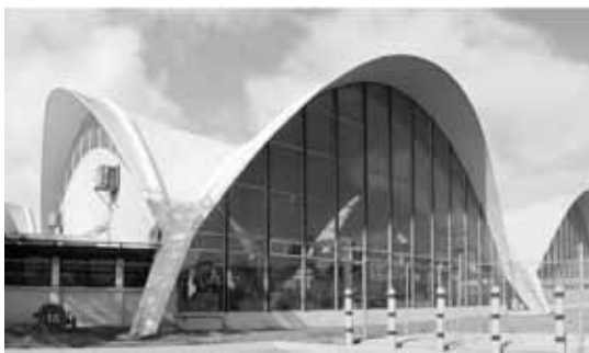
Bordes libres. Tres conjuntos de bóvedas independientes agrupadas 2 a 2. Planta Bacardí (1958-1960) junto al Ing. Luis Torres Landa. Cuautitlán, estado de México. Fuente: http://sitioaureo.blogspot.com/2010/08/felix-candela-y-la-arquitectura.html
