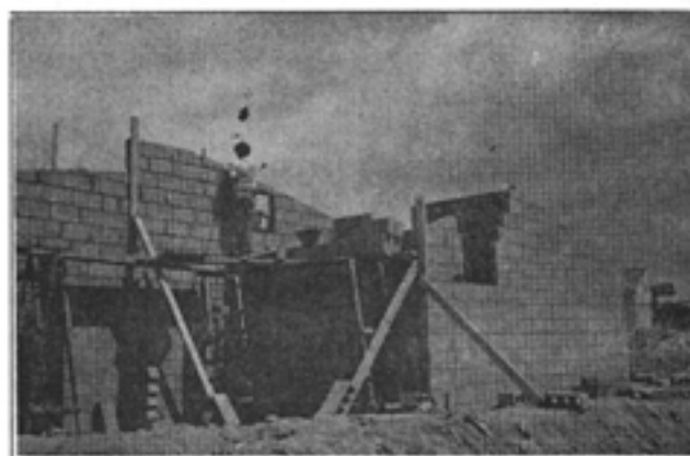
TERMINACION DE ETAPA DE CONSTRUCCION DE MUROS
