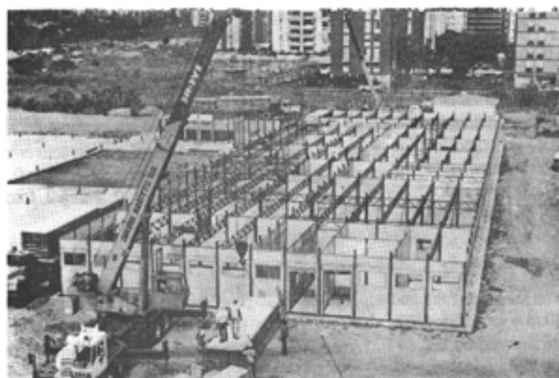
1 Proceso de montaje en planta baja.
