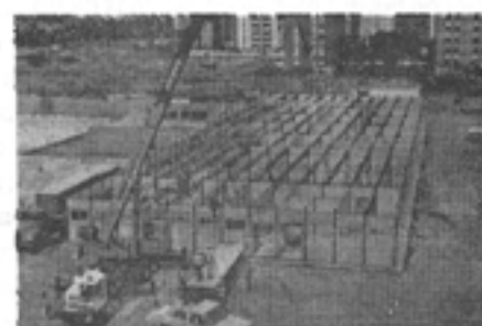
Etapas del montaje.
