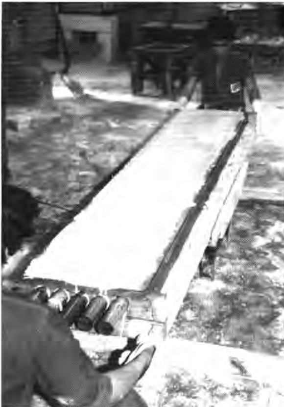
Foto 1. Fabricação experimental de um painel de argamassa de cimento alternativo, reforçada com fibras de coco.
