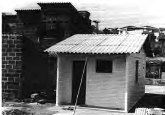
Foto 2. Protótipo construído em 1989, em São Paulo, empregando painéis com o cimento alternativo.
