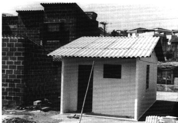
Foto 2. Protótipo construído em 1989, em São Paulo, empregando painéis com o cimento alternativo.
