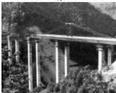
Foto 16 Viaducto Semorile, puente deslizante
