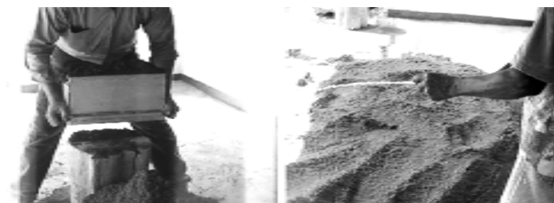
Fotos 5 y 6 Proporciones de mezcla y calidad de vibrado a juicio del obrero
