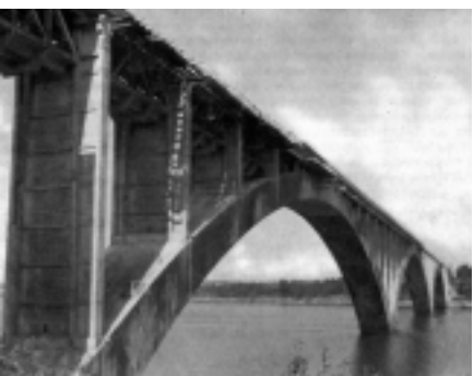
Foto 11 Puente sobre el Elorn, Francia
