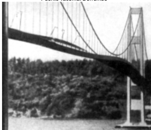
Foto 21 Puente Tacoma. Derrumbe
