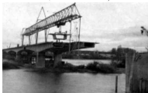
Foto 14 Puente Loira, colocación de dovelas prefabricadas
