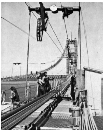
Foto 20 Puente Mackinac. Tendido de los cables
