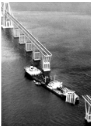
Foto 25 Puente sobre el lago de Maracaibo. Derrumbamiento
