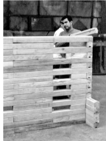
Fuente: Mampostería estructural con madera de pino caribe de pequeños diámetros. (foto: MRJ).
