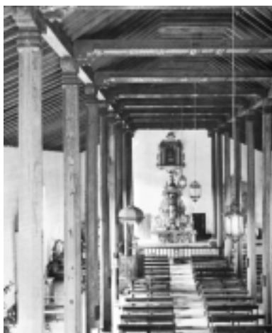
Fuente: Estructura y techumbre del templo de Obispos, Estado Barinas, Venezuela. Foto: G. Gasparini. En Gasparini, 1965.
