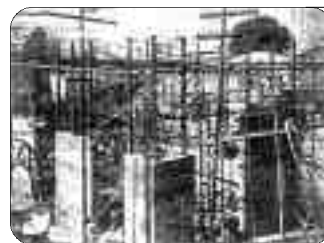
Foto 10: Construcción a prueba de temblores en la esquina de Traposos
