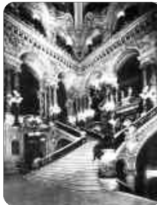
Foto 2: La escalera de la Ópera de París una vez terminada. Charles Garnier, 1861-1874
