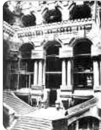
Foto 1: La escalera de la Ópera de París en construcción. Charles Garnier, 1861-1874
