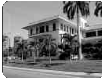
Foto 3: Hospital Coromoto. Maracaibo
