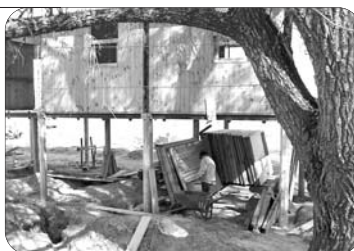
Foto 4: Preparación de materiales para la construcción de viviendas
