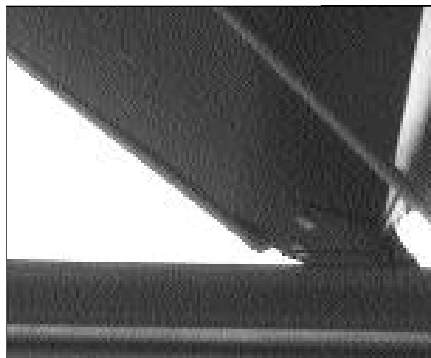
Figura 52 Dobleces en las láminas (producidos por caminar sobre ellas)
