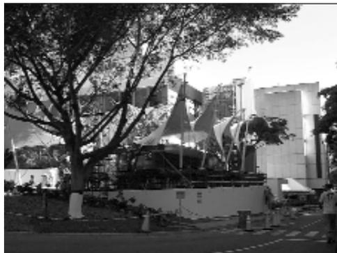
La tercera cubierta es un paraboloides soportado por un mástil en un extremo que produce un punto alto y dos puntos bajos que van directo a las fundaciones, en el otro extremo la membrana se monta sobre un pasillo cubierto y se sujeta a la viga de éste a través de cinco bases (ver foto 24).
