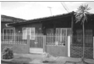
Foto 1 Vivienda AC-1 Rubio, estado Táchira
