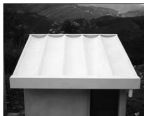
Figura 3 Sistema de techo en base a lámina metálica-Sitech. Una respuesta para la vivienda de bajo costo de construcción progresiva en Venezuela. Arq. Beatriz Hernández
