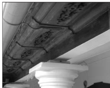
Figura 14 Piezas ornamentales ensambladas entre los canecillos en aleros hacia el patio principal.
