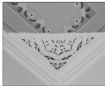
Figura 19 Pieza ornamentada en vértice de cielo raso de la Casa Pastor Dacosta.
