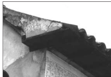
Figura 13 Cambio de pendiente en alero de cubierta, en la Casa Biaggini.
