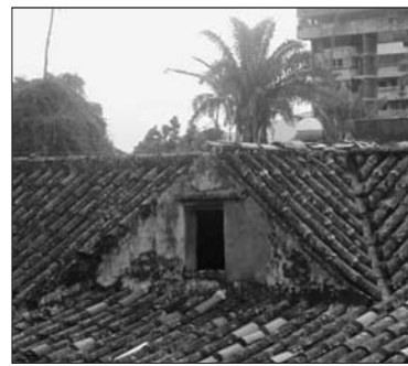
Figura 18 Abertura al exterior en cubierta del Colegio Santa Bárbara.
