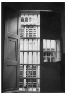
Hojas practicables y postigo en ventana interior
