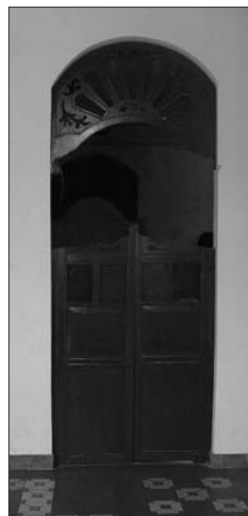
Portón cancel con tímpano decorado con caladuras y fanlight
