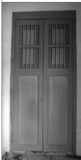
Portalón interior con barrotes en perforación superior
