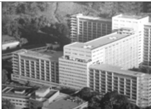
tra la intención de adaptar el esquema moderno tanto a las necesidades locales como a las condiciones climáticas. El uso de las romanillas y quiebrasoles muestra la tropicalización de la arquitectura moderna.
