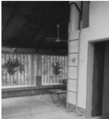
Foto 28 Contraste de colores en elementos de herrería (imagen tomada durante el proceso de pintura de la obra)
