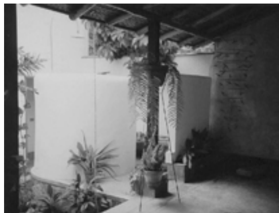
Foto 13 La ducha vista desde el corredor (foto tomada durante el proceso de pintura de la obra)
